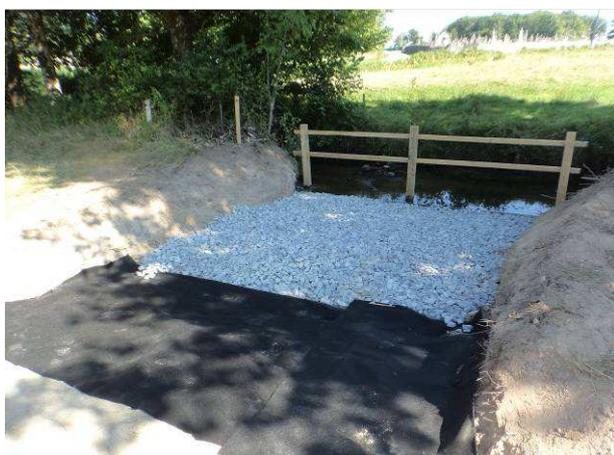
Descente empierrée : terrassement et pose d'un géotextile
