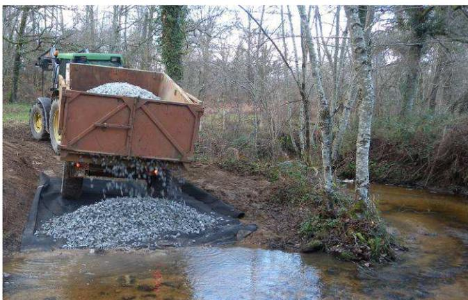
Pose d'un géotextile et empierrement
